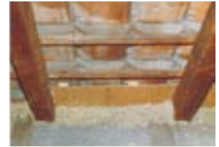
Dachschräge mit Rockwool Granulat gedämmt (mit Hinterlüftung)
