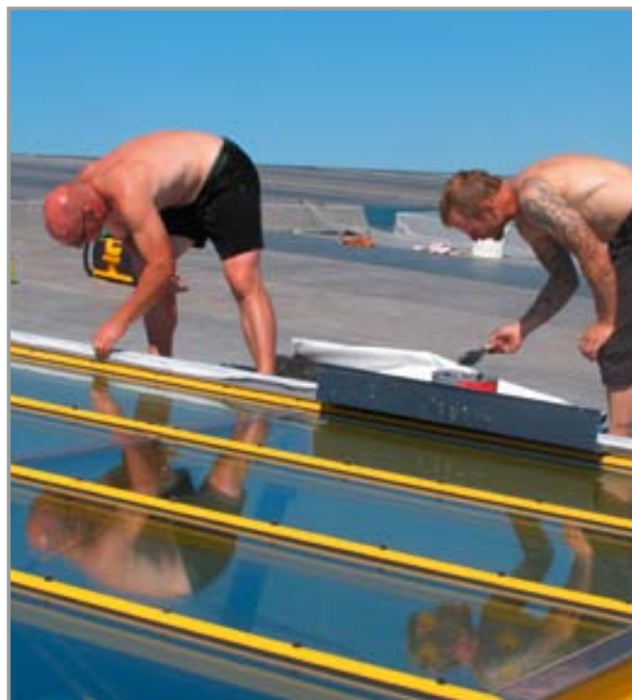
Mitarbeiter der Fa. Jörg Apfelstädt bei Arbeiten an einem Oberlicht der Haupthalle
