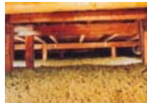
belüftetes Flachdach gleichmäßig gedämmt
