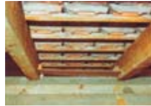
Dachschräge, vorbereitet für das Einblasdämmsystem
