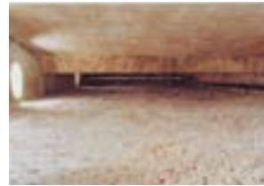
belüftetes Flachdach vor dem Einblasen des Rockwool Granulates
