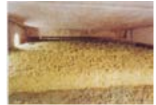
belüftetes Flachdach mit Rockwool Granulat gedämmt
