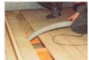
Dämmung einer Holzbalkendecke mit Rockwool Granulat
