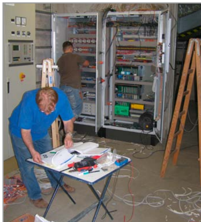
Die Steuer- und Schaltanlage, die die Wärme- und Stromerzeugung des Erlebnisbades regelt, wurde in nur einer Nacht ausgetauscht.
